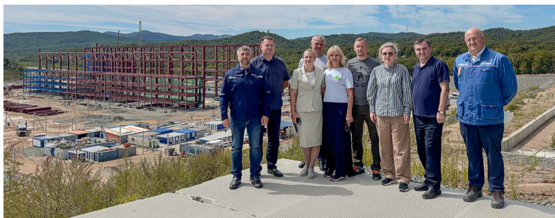
Ⓢ В рамках работы ВЭФ Роман Бердников проинспектировал ход строительства АТЭЦ-2 и провел выездное совещание с представителями Газпромбанка. Фото: Александра Зуева
