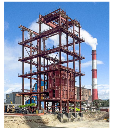
Ⓢ Энергетики уже возвели каркас котлоагрегата № 1. Фото: Александра Зуева
