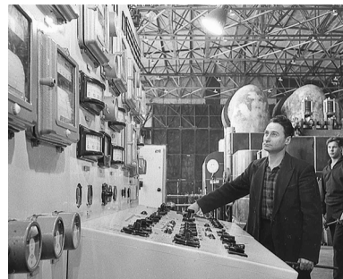
© Турбинный цех ТЭЦ-1, 1967 год. Фото: из архива Музея энергетики ДГК
