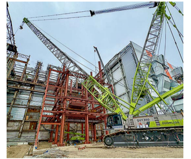
Ⓢ Смонтировано уже 200 тонн металлоконструкций — большая половина каркаса котла. Фото: Александра Зуева
