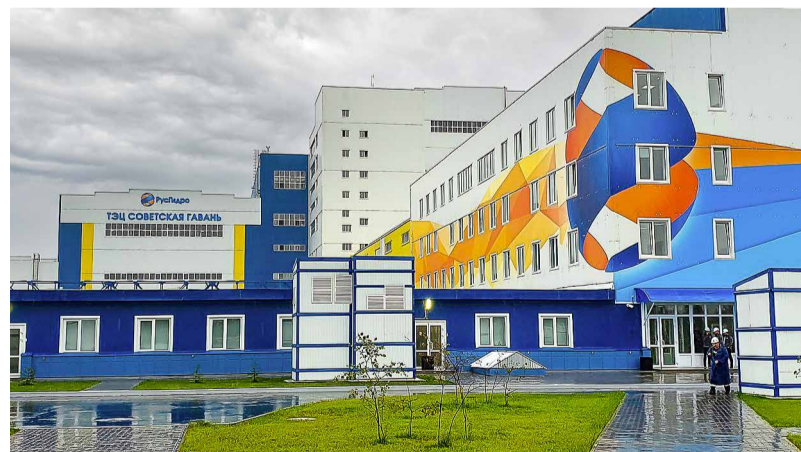
© Свой четвертый отопительный сезон Совгаванская ТЭЦ отработала полным составом оборудования с номинальной мощностью. Фото: открытые источники
