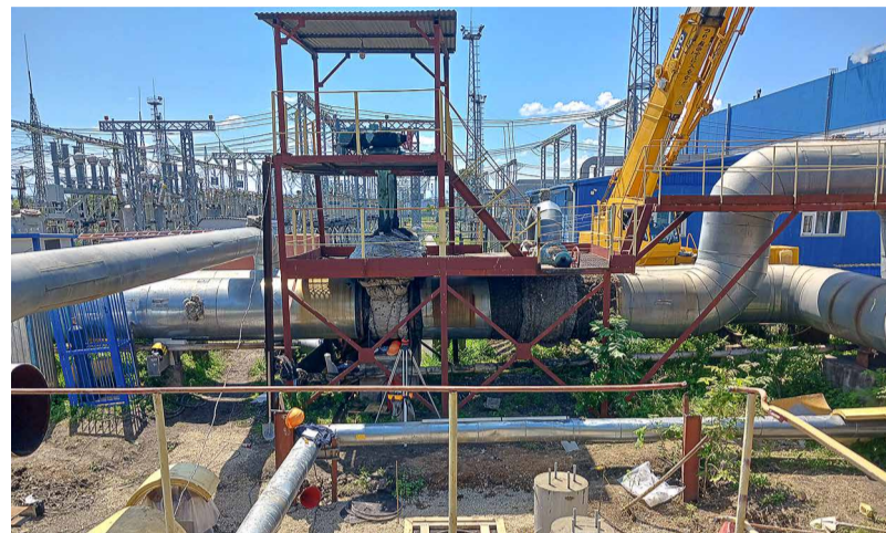
© Демонтаж технической части тепловых сетей на узле «А», откуда выходят все тепловые артерии Благовещенска. Фото: Анна Баклыкова
