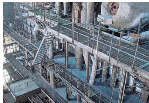
© Энергетики Артемовской ТЭЦ вывели в средний ремонт котлоагрегат № 13
