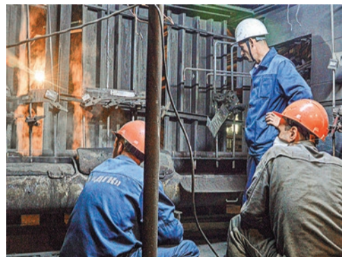
© Горячая ремонтная пора на Биробиджанской ТЭЦ
