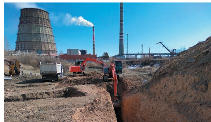
© Общая протяженность трубопровода от АТЭЦ-1 до насосной станции составит 700 метров
