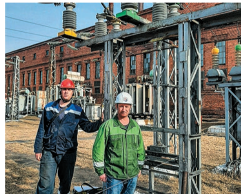
© На Комсомольской ТЭЦ-1 часть устаревших фарфоровых изоляторов заменили на более надежные полимерные
