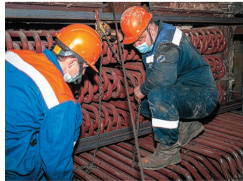
© На КТЭЦ-1 меняют змеевик водяного экономайзера котлоагрегата
