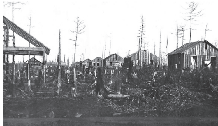
Строительство дощатых домиков для строителей эл. станции. 1936 г.
