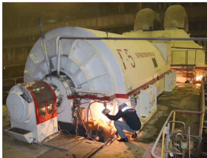
На блоке № 5 завершены ремонтные работы
