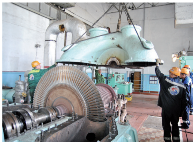
Ремонт турбоагрегата на Майской ГРЭС. Август 2017 г.
