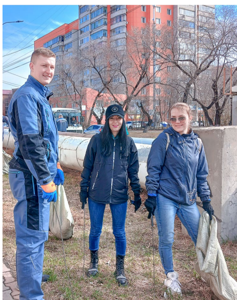
© Работники АТС и БТЭЦ расчистили подъезды к тепломатриалам города и подготовили сети к предстоящим ремонтам. Фото: Анна Баклыкова
