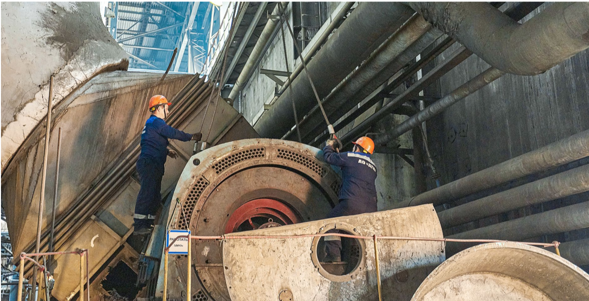
© Работы в котельном цехе Благовещенской ТЭЦ. Фото: пресс-служба ДГК
