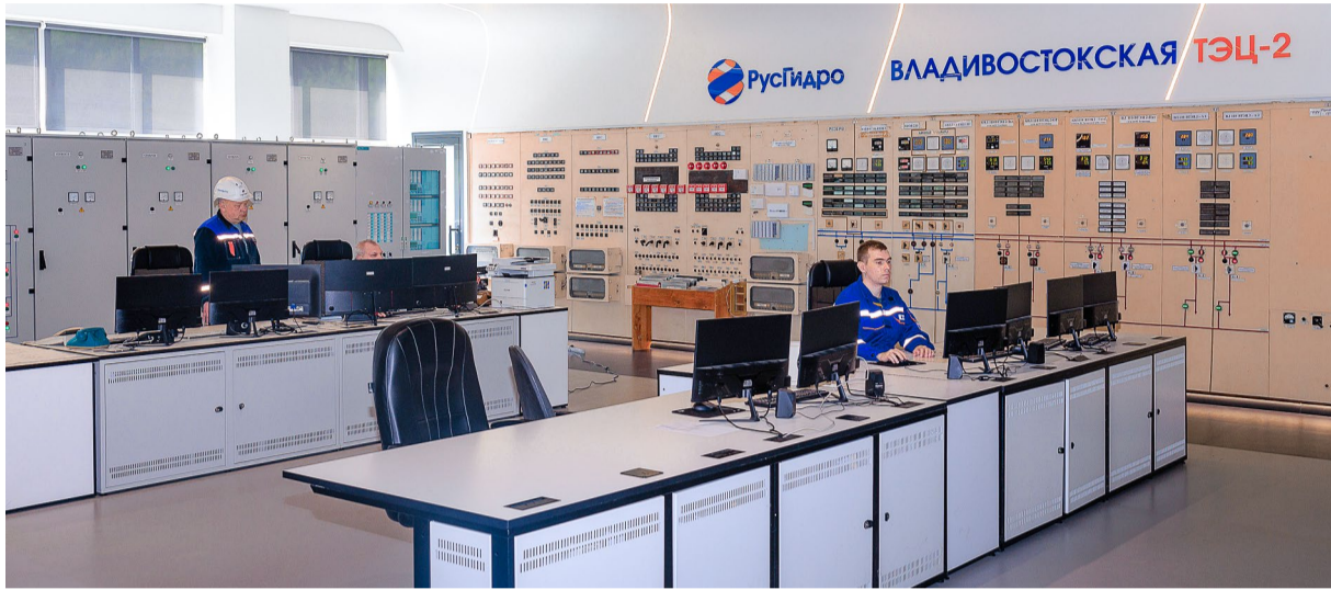
© Модернизация ВТЭЦ-2 предусматривает замену трех наиболее изношенных турбоагрегатов, монтаж трех новых котлоагрегатов и ряд других работ. Фото: ИА Primamedia
