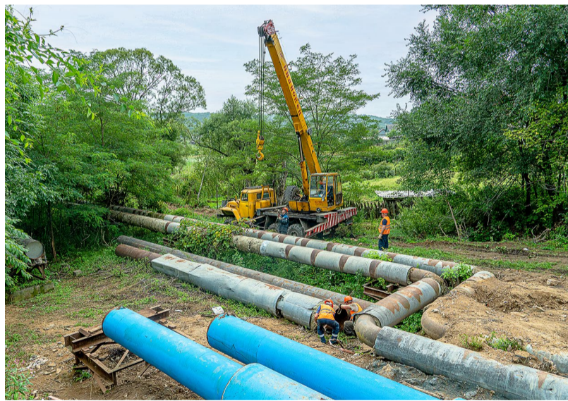
© Гаражи и другие постройки вблизи теплосетей не должны мешать проезду ремонтной техники. Фото: архив ДГК
