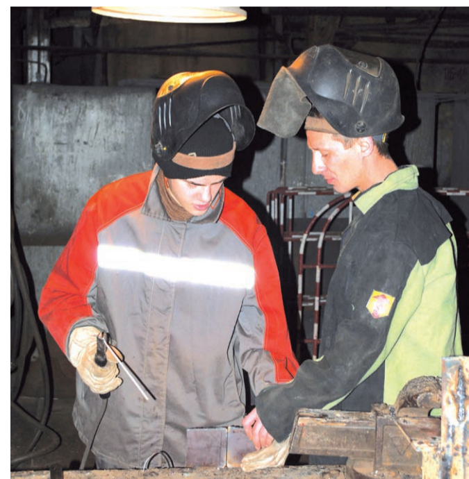
Андрей Воронков научился варить стыковой шов под присмотром наставника – сварщика турбинного цеха Сергея Толкачева
