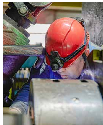
© Работы на оборудовании Благовещенской ТЭЦ. Фото: Анна Баклыкова
