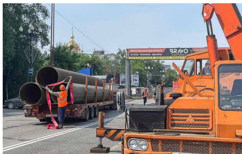
Ⓢ Несмотря на масштабы работ в 2024 году, энергетики нацелены на скорейшее завершение всех ремонтов. Фото: Семен Симоненко
