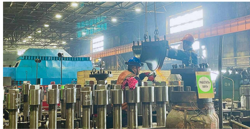
☉ В период ремкампании на НГРЭС проведут ремонт и обслуживание турбоагрегата № 2. Фото: Анна Неустроева
