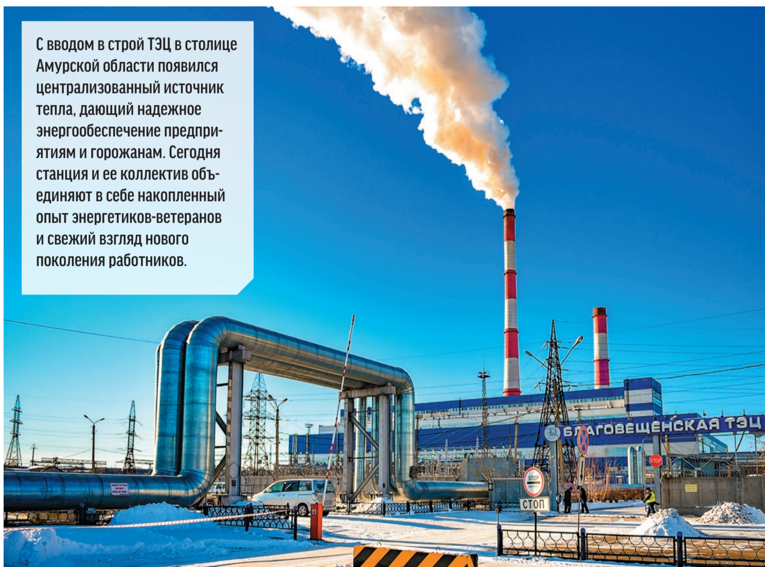
725 человек трудятся на самой крупной теплоэлектростанции Амурской области, обеспечивая регион теплом и электричеством. Фото пресс-службы Благовещенской ТЭЦ
