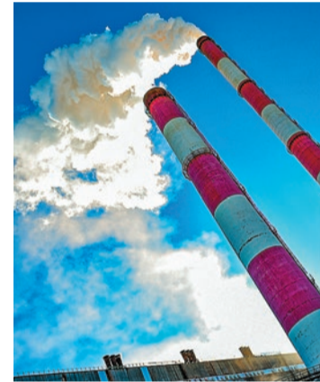
На Благовещенской ТЭЦ стремятся постоянно повышать экологичность производства и снижать вред окружающей среде. Фото пресс-службы БТЭЦ
