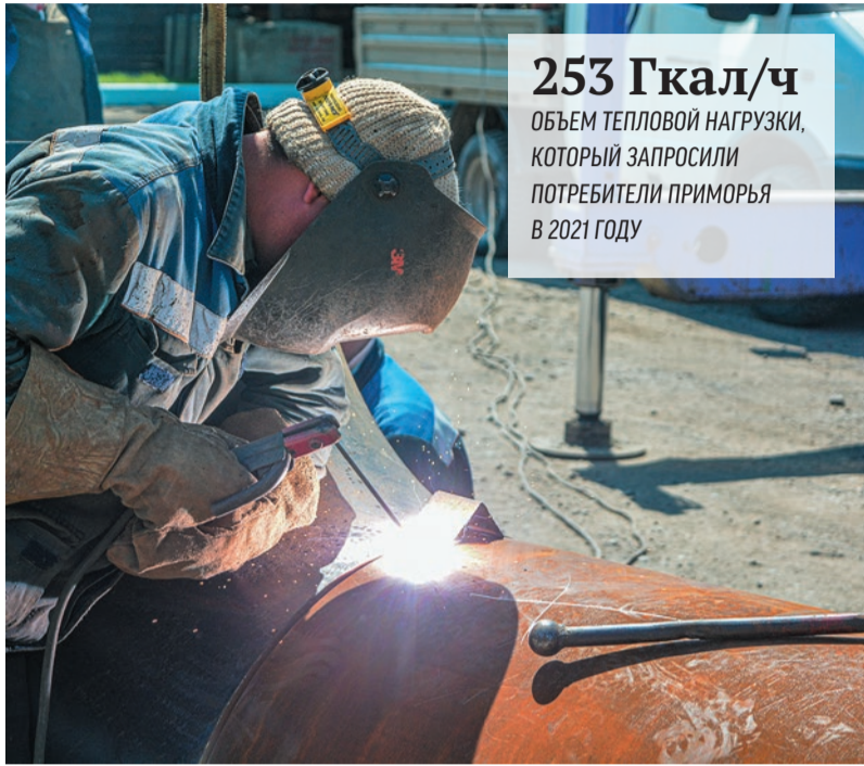
Чтобы справиться с возрастающей нагрузкой, теплотрассы должны быть полностью исправны. Фото пресс-службы ПТС
