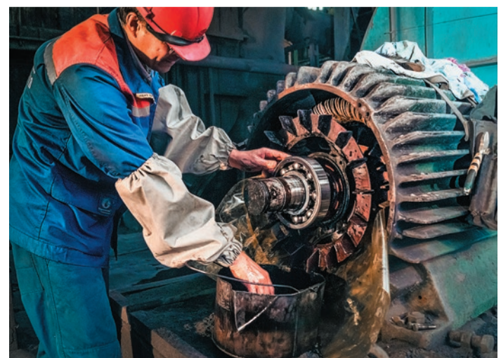
© Расширенный текущий ремонт котлоагрегата № 9 Биробиджанской ТЭЦ продлится до 4 июля. Фото Татьяны Евменовой
