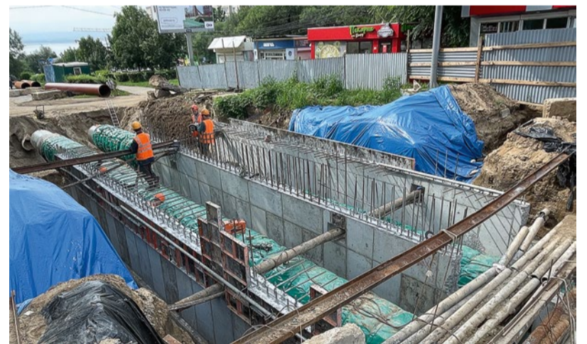
© Ремонт сетей на улице Ленина. Фото: Семен Симоненко
