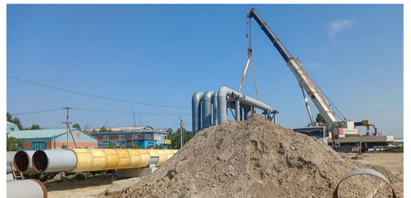
© Реконструкция тепломагистрали № 1 Центрального района Благовещенска. Фото: Анна Баклыкова
