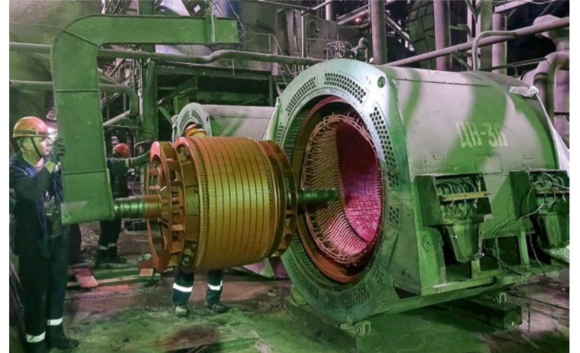
© Ремонт электродвигателя дутьевого вентилятора на котле № 3 Благовещенской ТЭЦ. Фото: Анна Баклыкова
