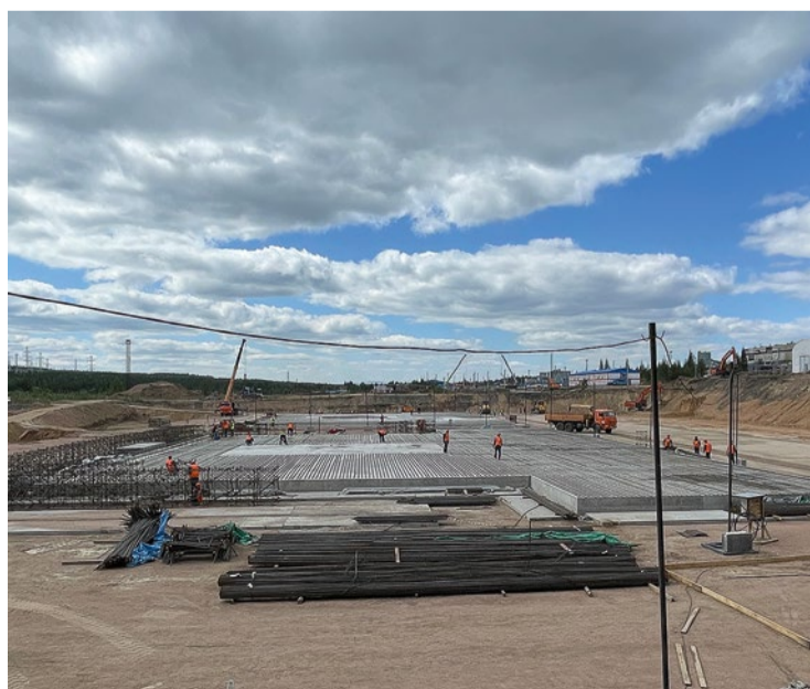
© Возводится основание фундамента для будущих энергоблоков № 4 и № 5. Фото: Анна Неустроева
