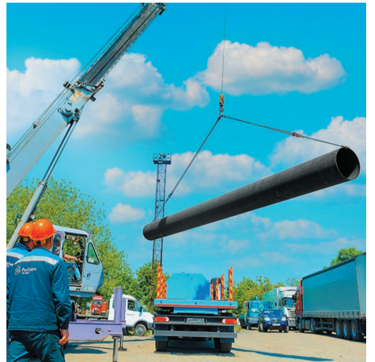
© Гидравлические испытания ПТС. Фото Екатерины Сенько
