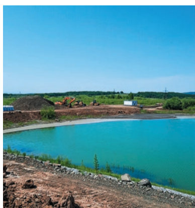
© До конца года чаша золоотвала ХТЭЦ-3 подрастет на шесть метров, и еще несколько лет станция сможет надежно работать.
