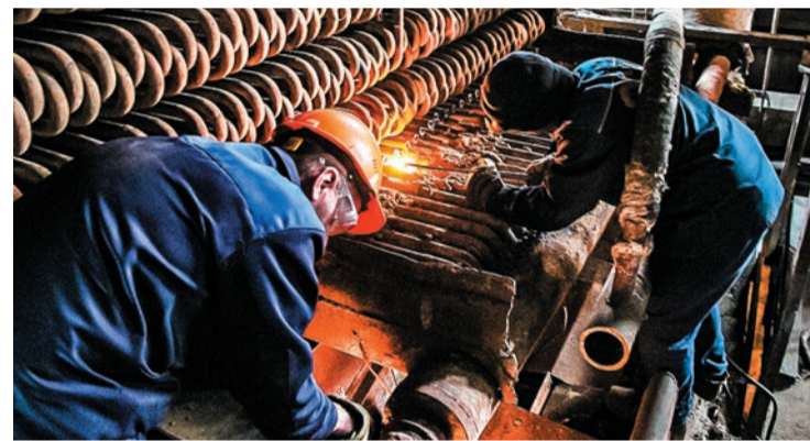
© Ремонт 45-метрового котла потребует больше двух месяцев.
