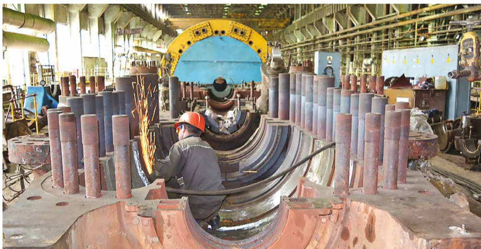
Ремонт турбины на Владивостокской ТЭЦ-2 в 2016 году
