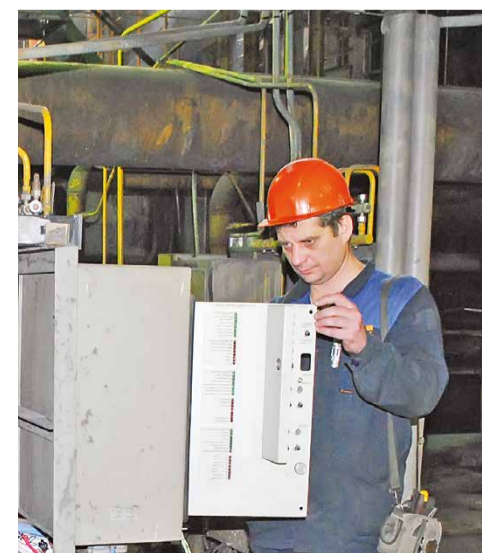
Старший мастер ЦТАИ Максим Донцов на ремонте узла связи с объектом горелки № 6
