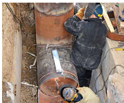
Подключение временной теплотрассы к основной схеме теплоснабжения
