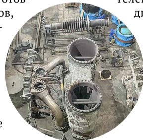
Оборудование энергоблока разбирали полностью. Фото: Семен Симоненко
