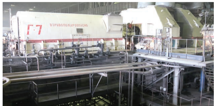
После капитального ремонта энергоблок №7 Приморской ГРЭС прошел аттестационные испытания
