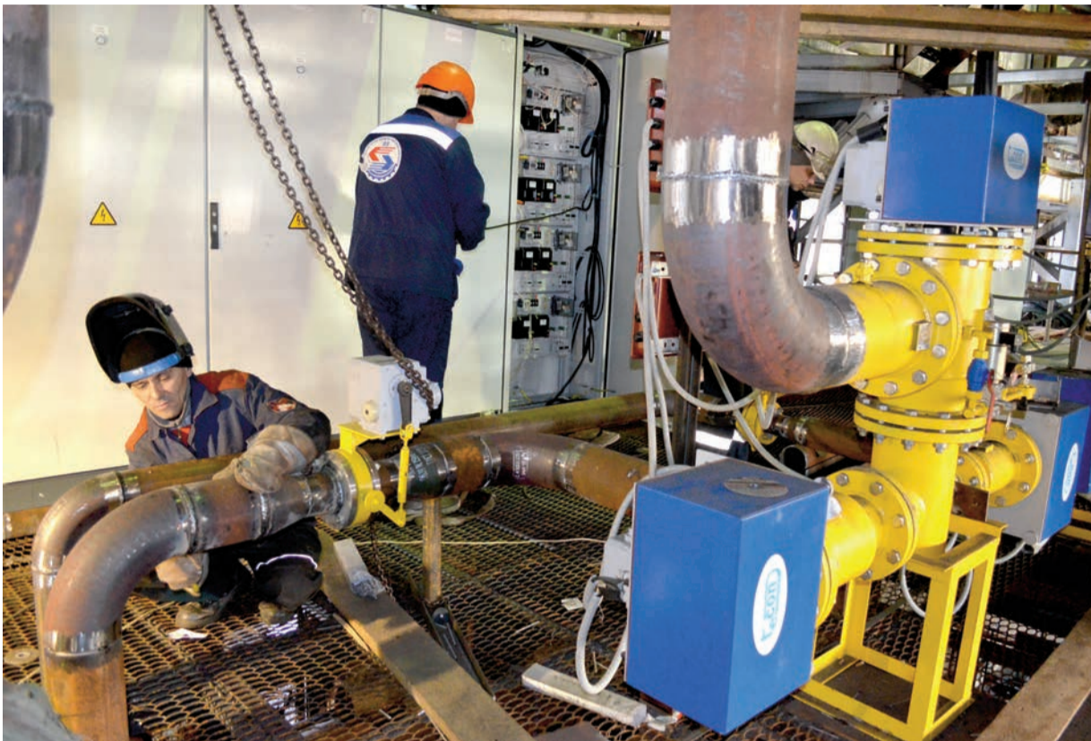
Идет монтаж газового оборудования для котла пиковой котельной ХТЭЦ-3
