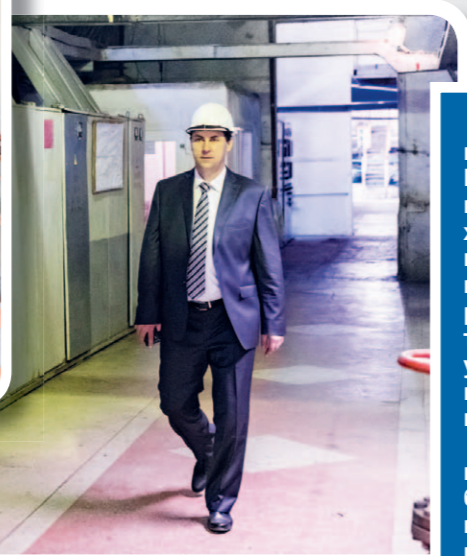
Главный инженер станции Александр Беляев производит обход котельного цеха
