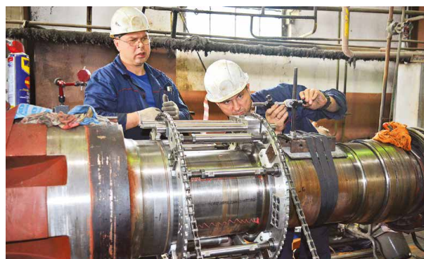
Проточка вала генератора на Партизанской ГРЭС
