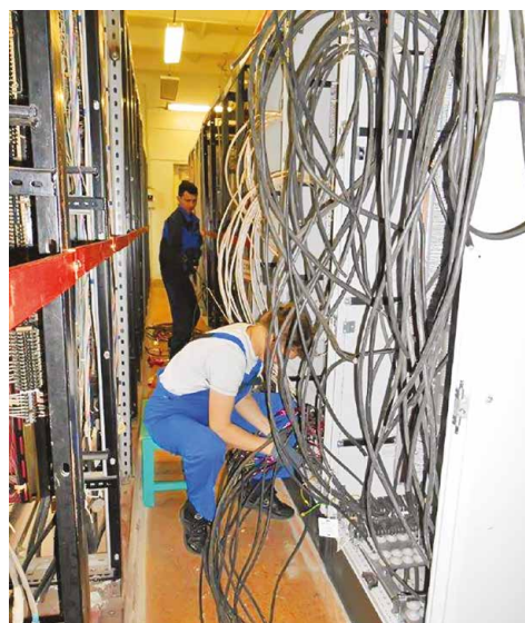
■ Монтаж кабельных трасс
