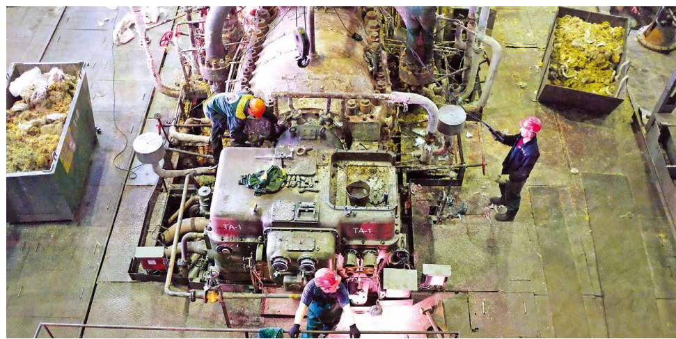
1-й энергоблок Хабаровской ТЭЦ-3 был в капитальном ремонте около 100 дней
