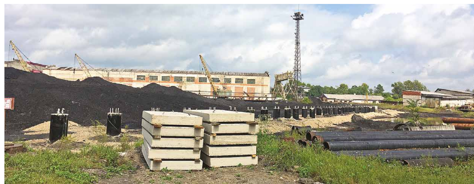
■ Строительство шумозащитного экрана
