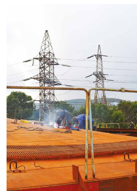
Монтаж крыши бака-аккумулятора
