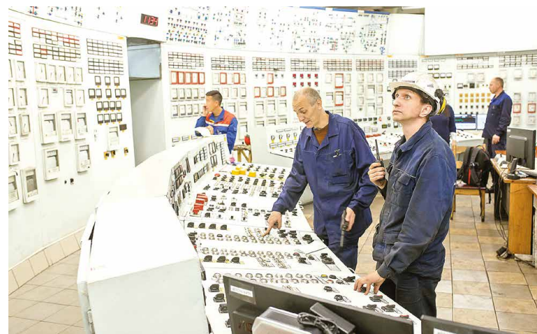
■ БЩО 1: настройка арматуры по окончании капитального ремонта
