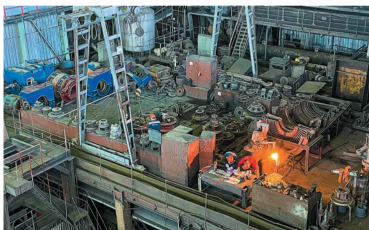
© На ТЭЦ-3 продолжается плановый ремонт оборудования
