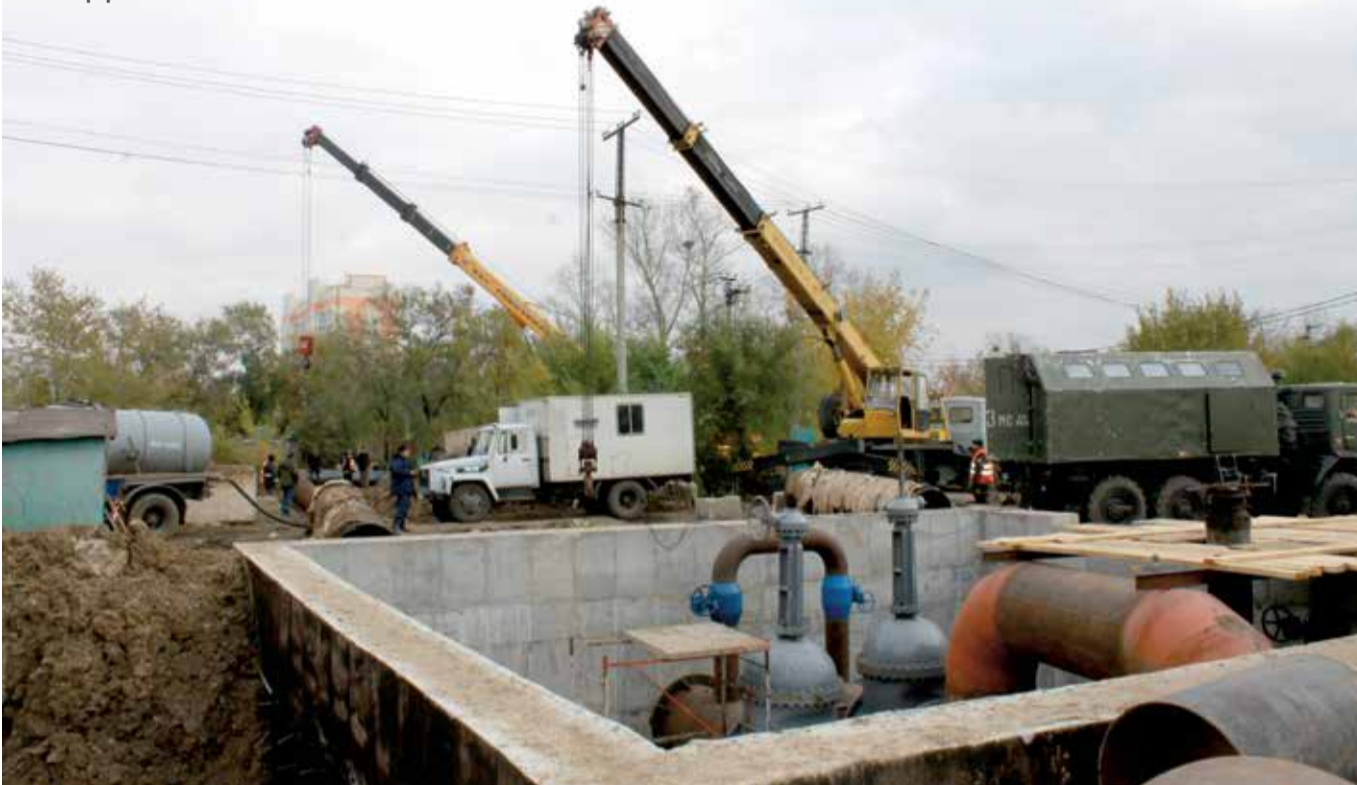
Работы по устранению порыва
