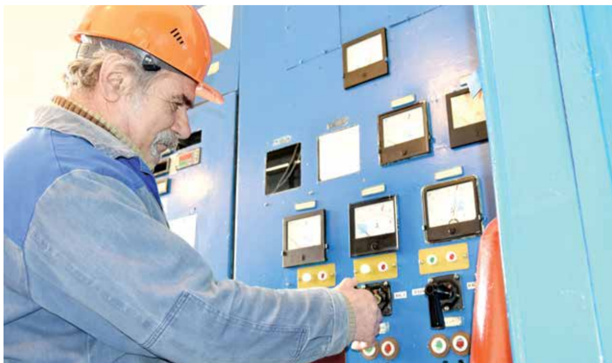
Оператор станции 2-го подъема Майской ГРЭС Владимир Сычев у пульта управления включения насосов артезианской воды
