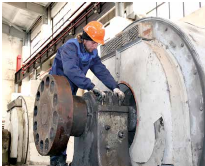
Ремонт – дело тонкое
